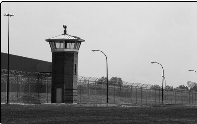
FIGURA 13. Las medidas de seguridad perimetral pueden incluir una torre de vigilancia y alambrado para evitar accesos no autorizados desde el entorno.
