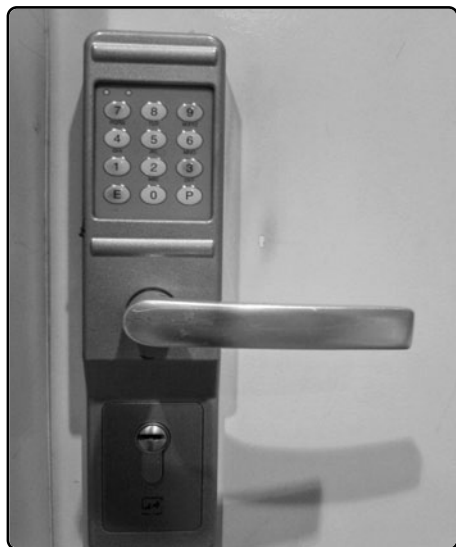
FIGURA 18. Las cerraduras electrónicas cuentan con su propio sistema de alimentación
