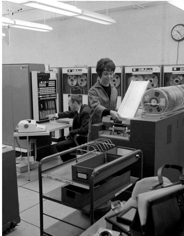
*Figura 1.1 Computadores IBM 7040 y 7044 en un centro de computación en 1964.*
